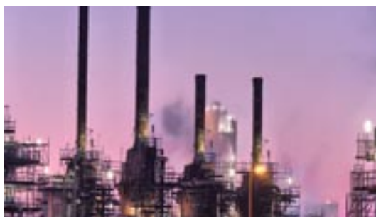
Maintenance générale ateliers de mécanique entretien
